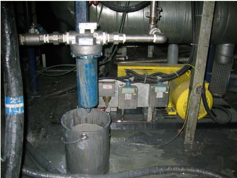
Feinfilter Kreislaufmedium
