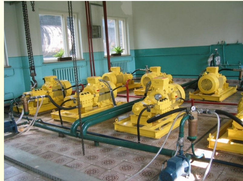
HD-Pumpenmodule
