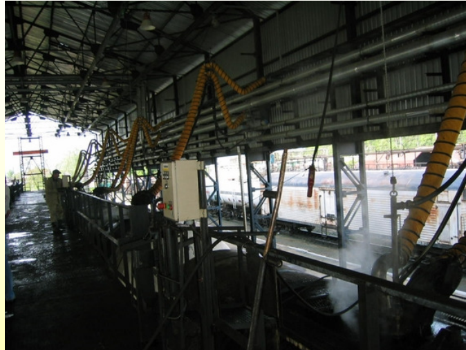
Zentraler Laufsteg zur Bedienung
