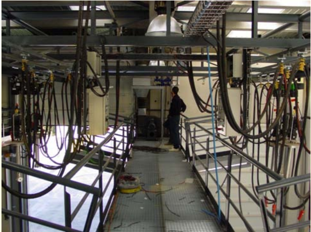
Laufsteg zur Bedienung
