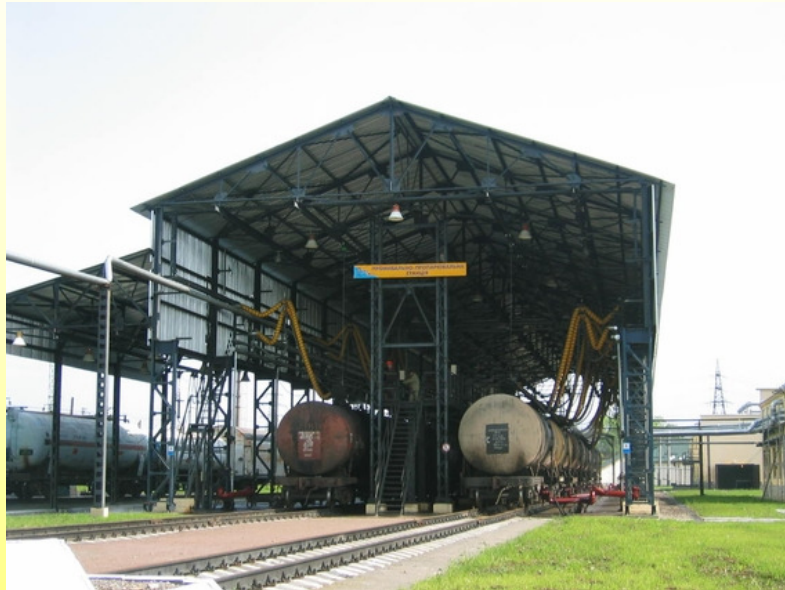
Reinigungslinien Straßentankfahrzeuge - Bahnkesselwagen
