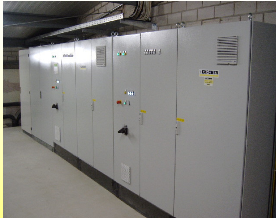
Hauptschaltschrank TSC SPS Steuerung
