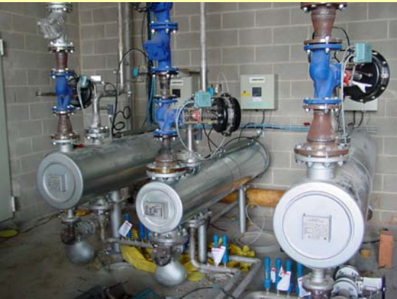
Warmwassererzeugung HD-Wärmetauscher
